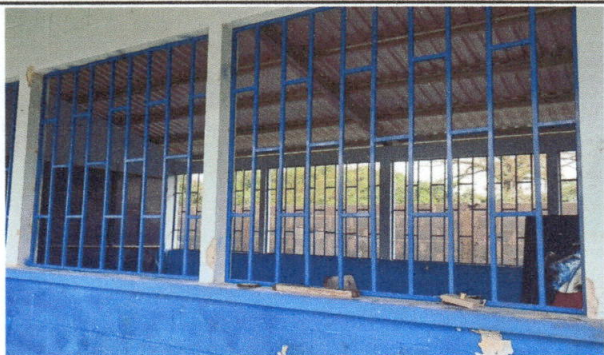
Foto 1: Instalación de balcones completada
