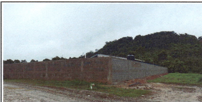
Foto 6: Mejoramiento de muro perimetral completado.
