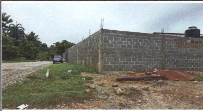
Foto 2: Mejoramiento del muro perimetral completado
