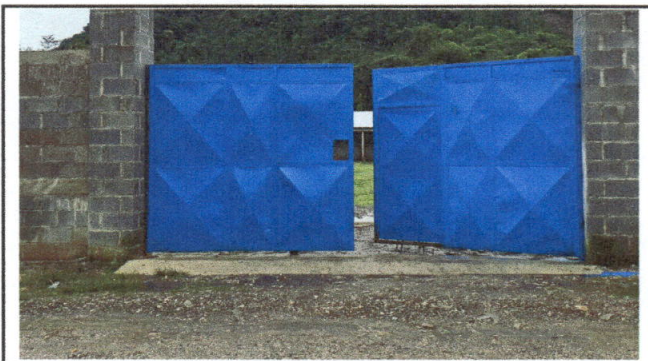
Foto 4: Instalación de portón metálico completado
